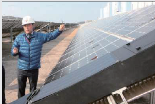
D발전소 설치 현장
